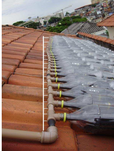
Figura 25: Falta de Linearidade no coletor solar.
